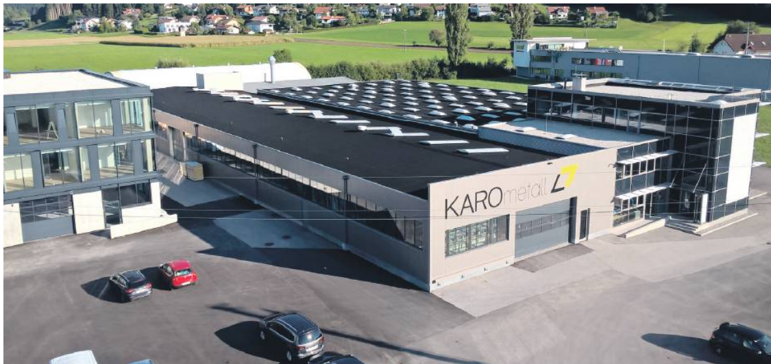
In den Phasen 1 und 2 wurden die Räumlichkeiten für KARO Metall um- bzw. neugebaut. Links im Bild das moderne Gebäude, das in Bauphase 3 entstand.
